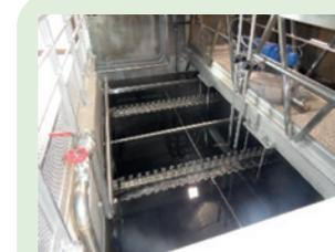
Une étape de traitement au chlore gazeux est systématiquement réalisée sur chacune des 32 ressources. Ce traitement est réglementairement obligatoire afin d'éliminer les micro-organismes potentiellement présents.
